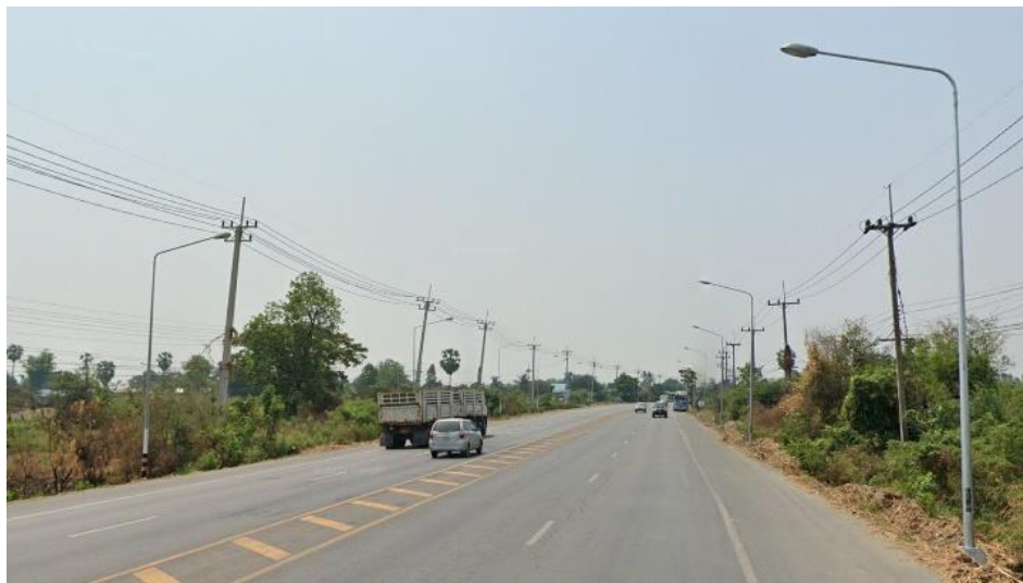
โครงการช่วงที่ 1 : ช่วง กม.11+950 ถึง กม.13+930
