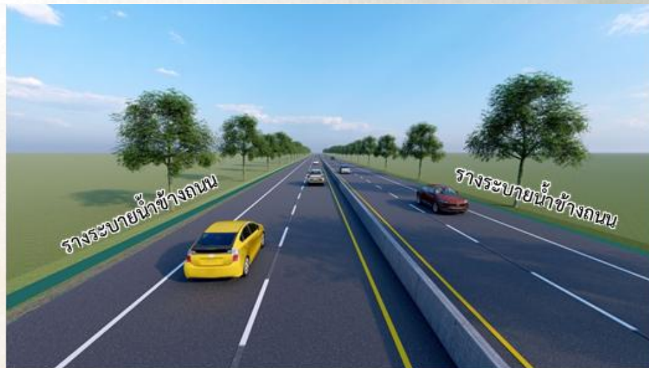
รางระบายน้ำข้างทาง - เกาะกลางแบบ Barrier Median กม.19+700 ถึง กม.21+000
