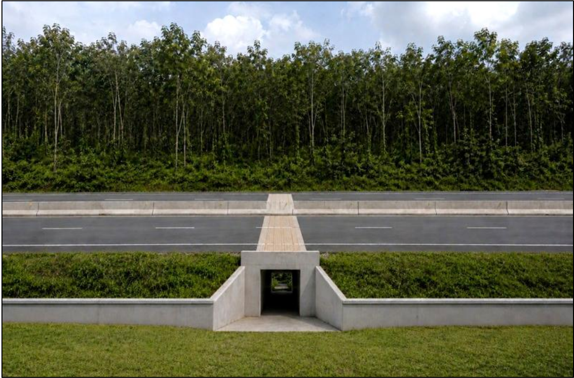
รูปที่ 5-21 ตัวอย่างท่อลอดเหลี่ยมและผนังนำทาง
