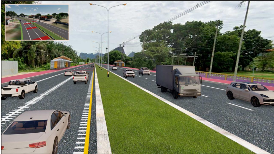
รูปที่ 5-12 ตัวอย่างการติดตั้งเครื่องหมายจราจรลดความเร็วบริเวณหน้าโรงเรียน
