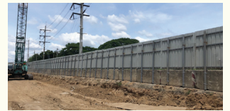
ตัวอย่างการติดตั้งกำแพงกันเสียงชั่วคราว
