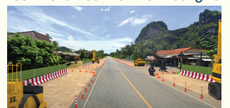
ตัวอย่างการจัดจราจรระหว่างก่อสร้าง
