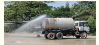
ตัวอย่างการฉีดพรมน้ำเพื่อลดการฟุ้งกระจายของฝุ่นละออง
